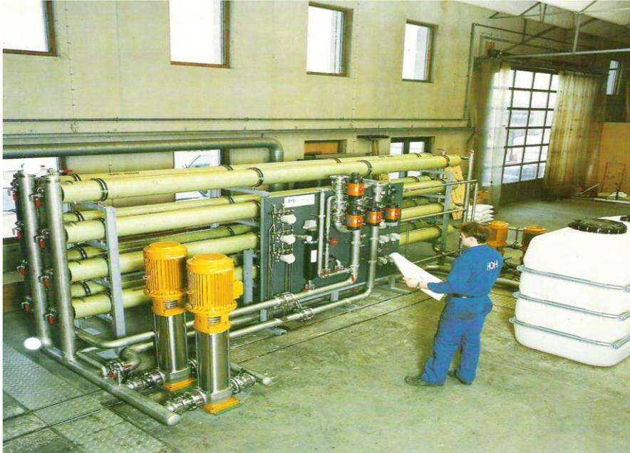
Figura 10. Instalación de membranas en planta tipo RO
