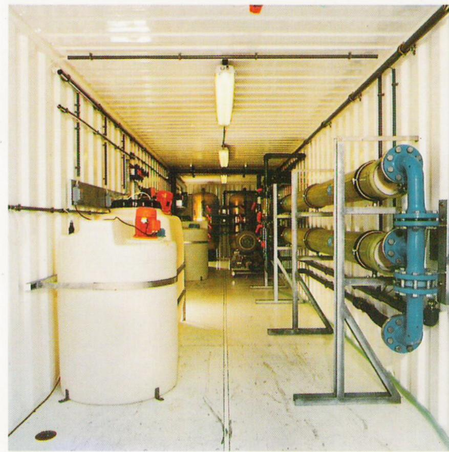
Figura 31. Planta desalinizadora tipo RO – modular -
